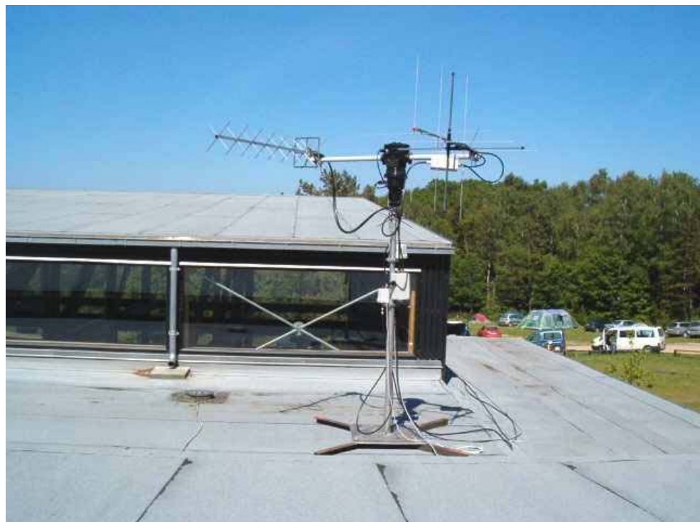
Antennerne kom op på taget af hovedbygningen på Sletten. Der er masser af træer, så det var en optimal løsning.
